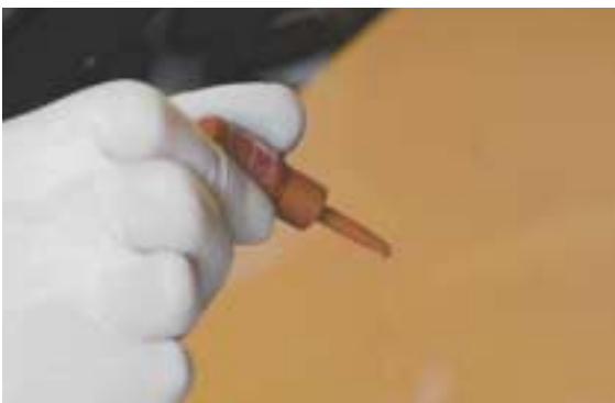
9 Aplicación de la resina de acabado en el punto de impacto y repetir las operaciones de los puntos 6, 7 y 8.
