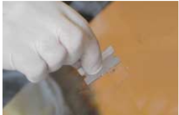
8 Retirar el exceso de resina con una cuchilla.
