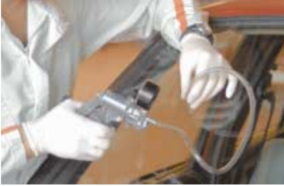
5 Extracción del aire interior y rellenado del daño con resina mediante el inyector.
